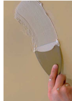
5. Enmasillado de las perforaciones
